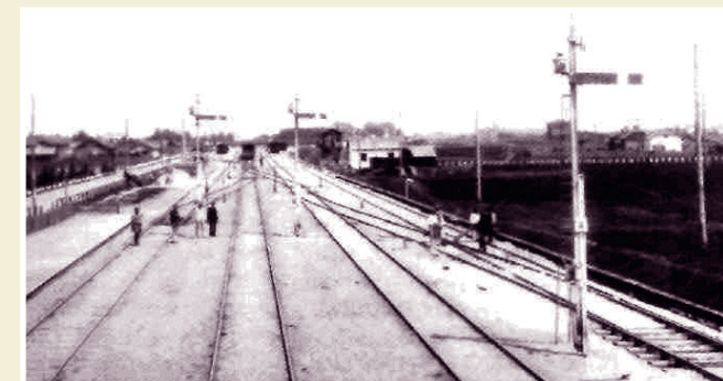
Четырехкрылые, двухкрылые и однокрылые семафоры на станции
