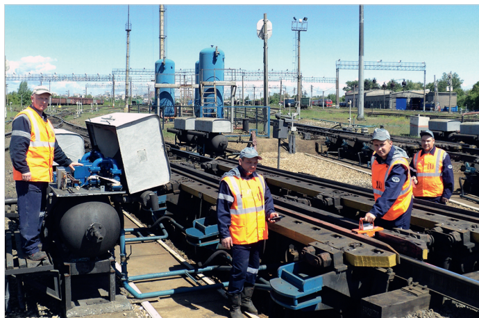
Старший электромеханик Д.К. Лаврентьев, электромеханик А.Н. Ярускин, слесари А.А. Поповсков и И.В. Сатаров проверяют усилия нажатия тормозных шин вагонных замедлителей
