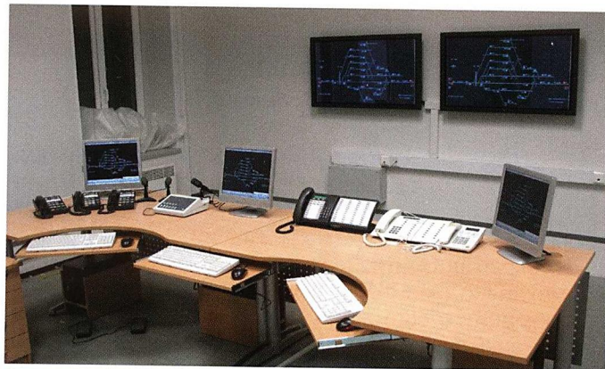
АРМ дежурного по станции в системе ЭЦ-ЕМ
