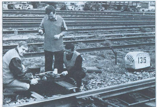
Старший электромеханик ЭЦ станции Голутвин А.Р. Измайлов, начальник участка Шиферная — Алпатьево Н.Н. Крючков и электромеханик ЭЦ станции Алпатьево А.А. Козлов за проверкой стрелочного электропривода
