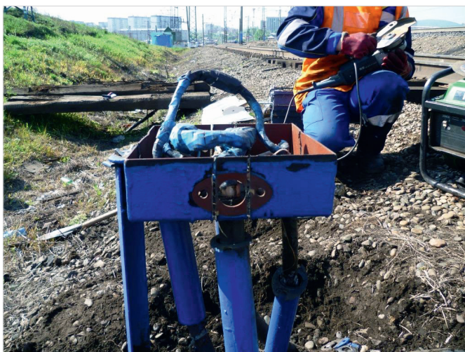
Демонтаж надземной кабельной муфты
