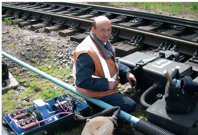
Электромеханик В.В. Пустошкин проверяет стрелочный электропривод на станции Москва-Товарная
