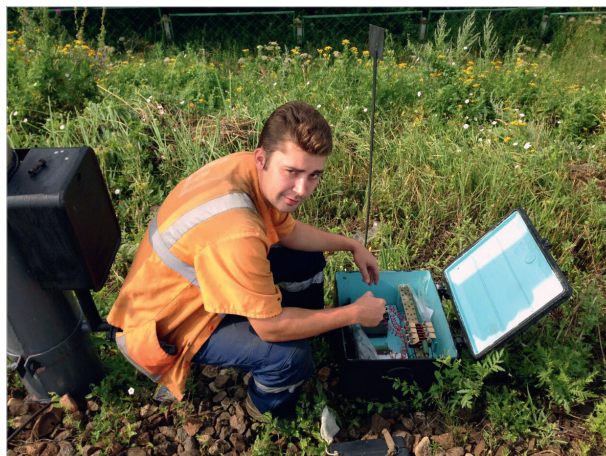
Старший электромеханик А.А. Шкута станции Подсолнечная регулирует параметры рельсовой цепи
