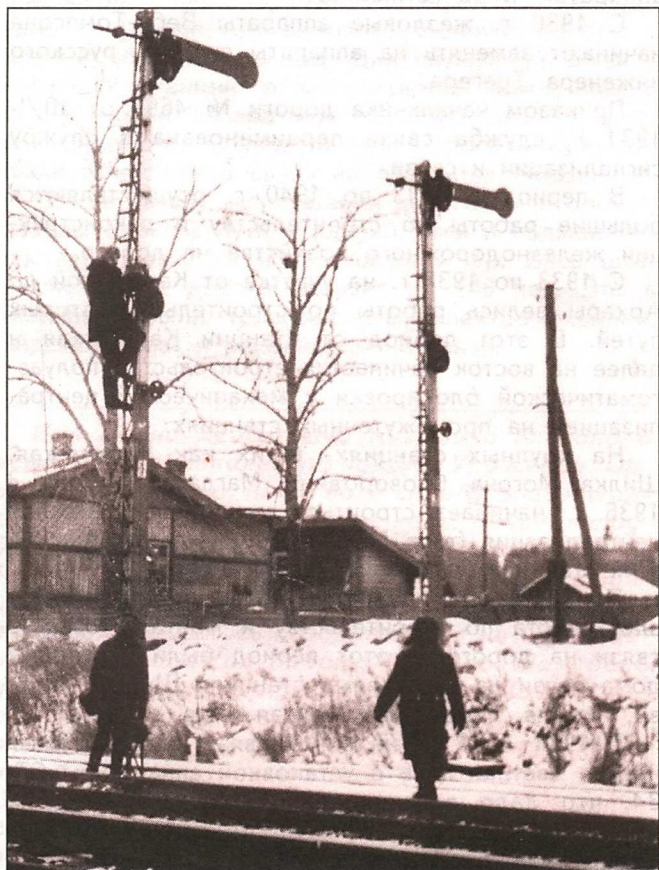
1970 год. Проверка семафоров на одной из станций Ерофей Павловичской дистанции
