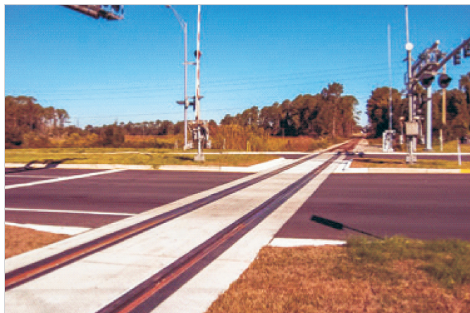
Специальные бетонные панели без шпал на переезде в штате Флорида
