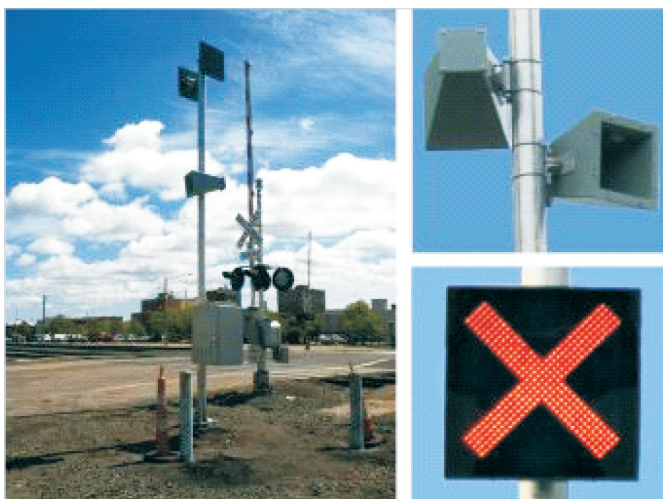
Система подачи звукового сигнала на переезде Wayside Horn System
