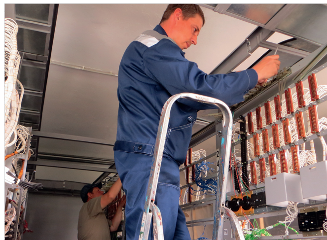
Монтаж статов в релейной на станции Кинель
