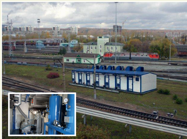
Замена централизованной компрессорной станции Инская Западно-Сибирской дороги на модульную
