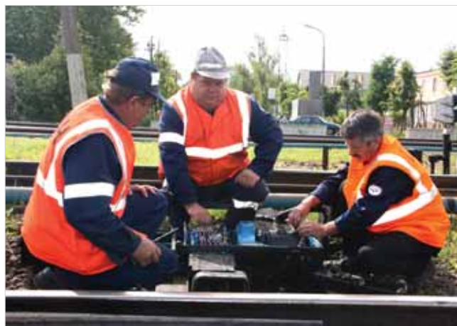
Электромеханики Е.Н. Горбунов, А.Е. Петров и старший электромеханик И.Б. Унтон проверяют состояние электропривода
