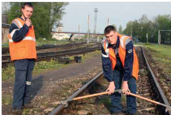
Электромеханики А.И. Васильев и А.П. Васильев накладывают шунт на рельсовые цепи
