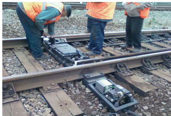
Стрелочный электропривод типа СПМ-150
