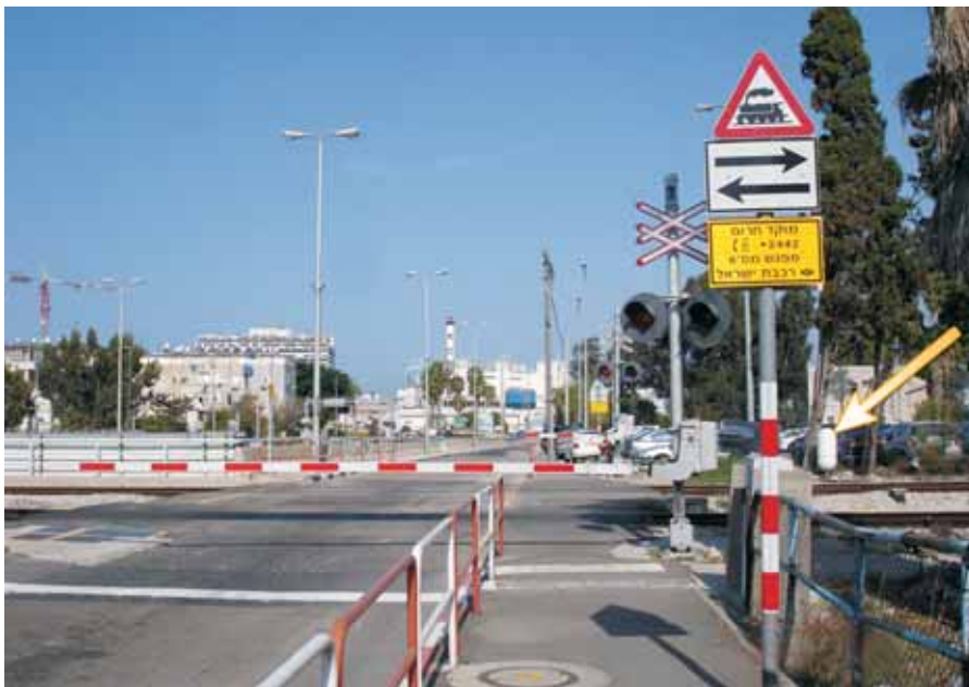
Система сканирования проверяет свободу зоны переезда и дает команду на закрытие шлагбаумов
