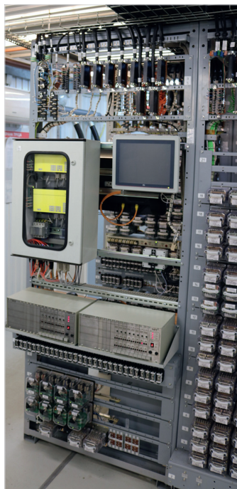
Статив с РКП-ЦМ и другими блоками микропроцессорного комплекса
