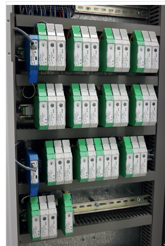
Вариант размещения оборудования подсистемы телеизмерения в релейном помещении
