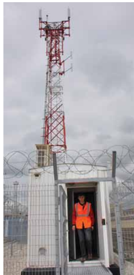
Модуль базовой станции цифровой системы технологической радиосвязи стандарта GSM-R
