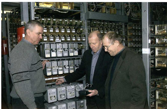
Начальник участка А.Н. Фоканов (справа) проверяет напряжение на путевых реле с электромеханиками А.А. Зубановым и Л.М. Синетутым
