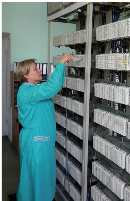
Прокладку кроссировки выполняет Я.З. Баранец
