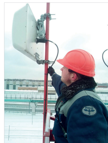
Регулировку параметров антенны системы GSM-R на МЦК производит электромеханик А.В. Егоров
