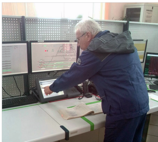
Электромеханик В.М. Еремеев проверяет работу пульта DICORA S15 системы GSM-R на станции Лефортово МЦК
