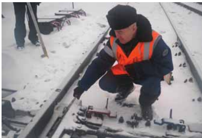
Г.Г. Шамин проверяет плотность прижатия остряка стрелки к рамному рельсу и контролирует напряжение на питающей панели
