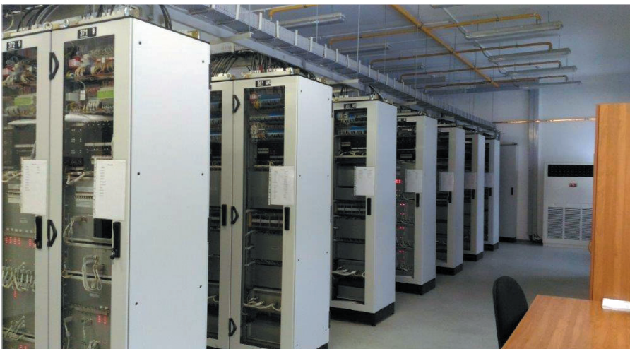
Шкафы с аппаратурой тональных рельсовых цепей АБТЦ-МШ в релейной на посту МПП
