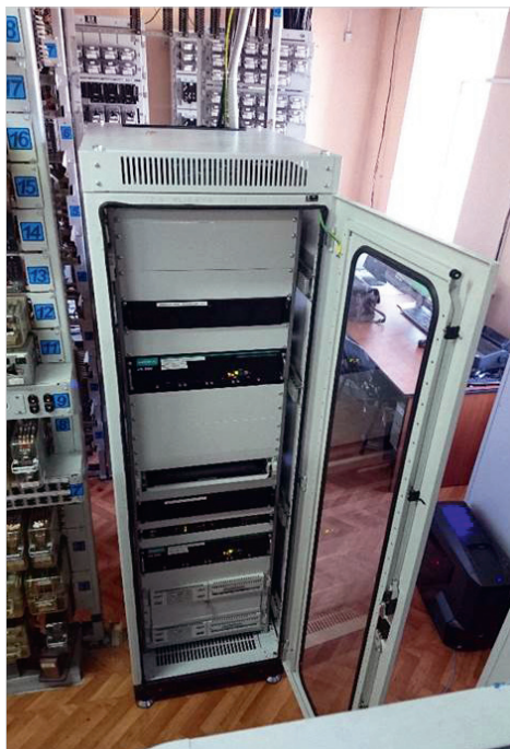
Микропроцессорная централизация стрелок и светофоров МПЦ-ЭЛ
