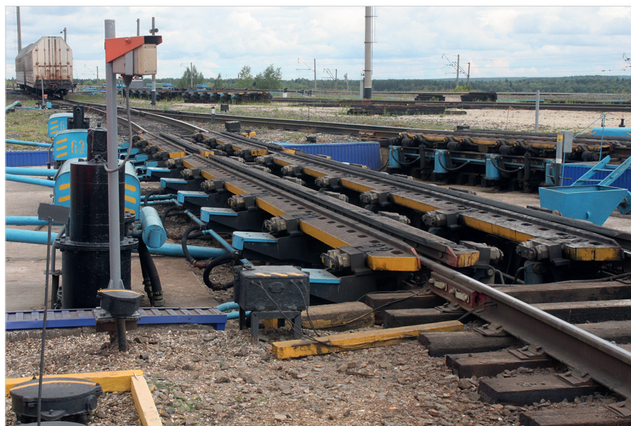
Вагонный замедлитель с пневматическим уравниванием тормозной системы КЗПУ 900-5-2
