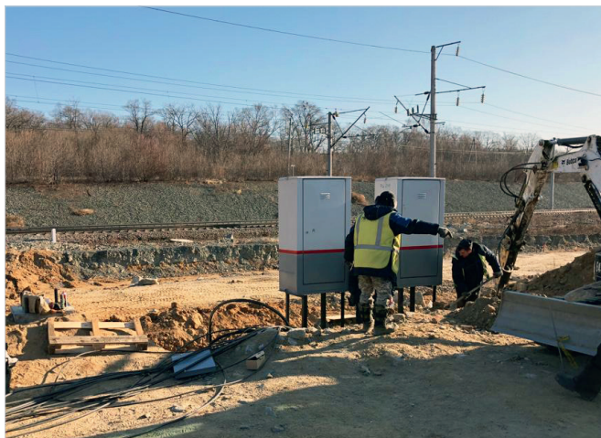
Установка релейных шкафов на примыкании парка «Новый» в порту Восточный
