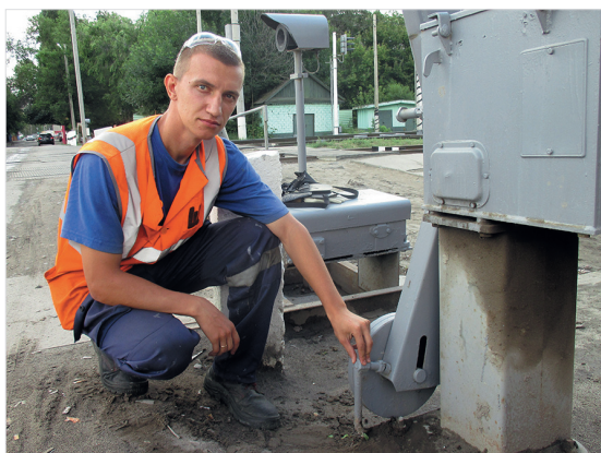
Реализация идеи старшего электромеханика В.А. Евдокимова гарантирует опускание ША при закрытии переезда
