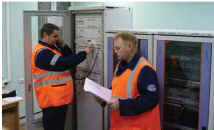
Старший электромеханик С.Н. Шинко и электромеханик Д.В. Обухов проверяют изоляцию линий парковой связи
