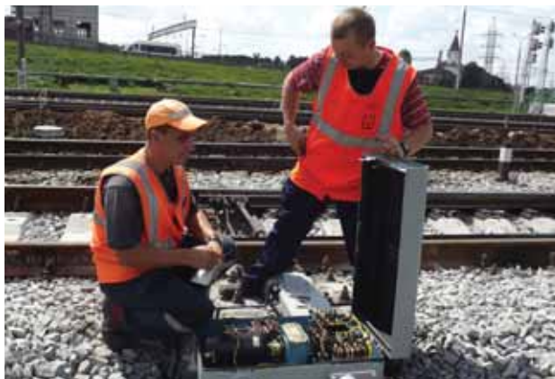
Электромеханик К.В. Проказов и монтер Д.А. Теребин во время проверки электропривода
