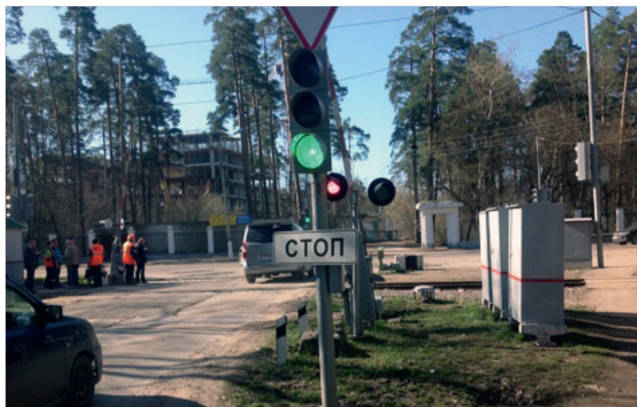
Установка двух разных транспортных (дорожных) светофоров
