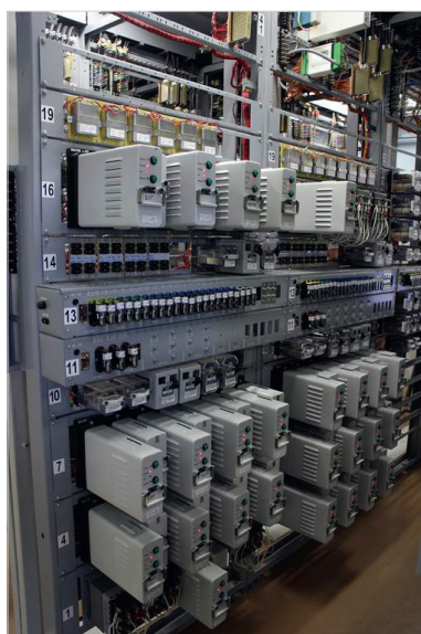
Микропроцессорные путевые генераторы и приемники ГМП1 и ПМП1
