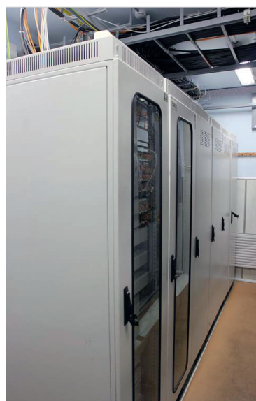
Оборудование МПЦ-ЭЛ, размещенное в 19-дюймовых шкафах – отечественных аналогах RITTAL
