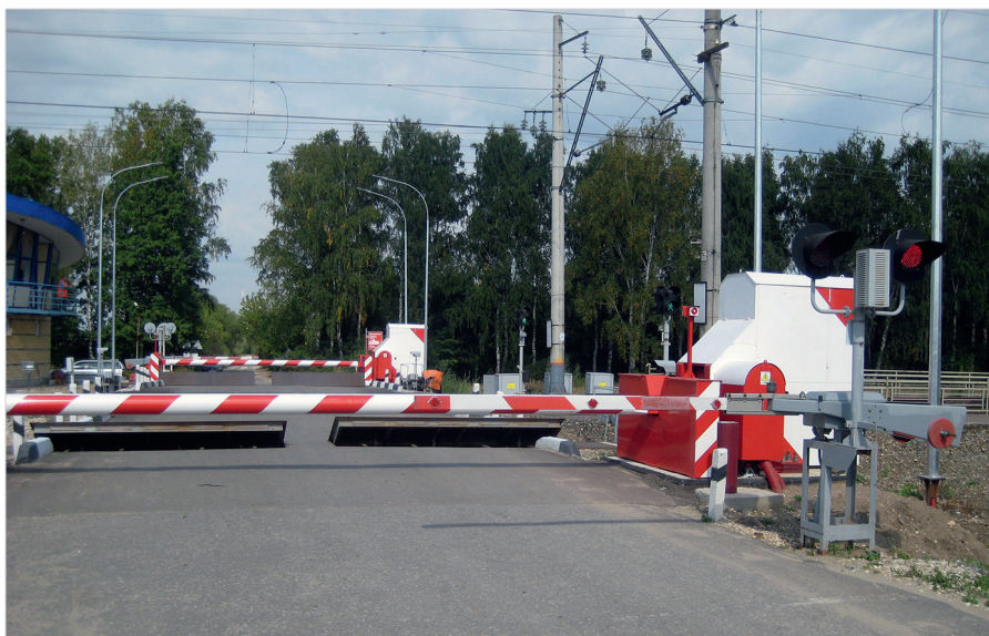
Переезд, оборудованный устройствами ограждения
