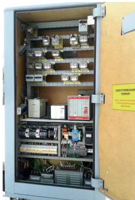
Релейный шкаф автоматической переездной сигнализации АПС-МП-М
