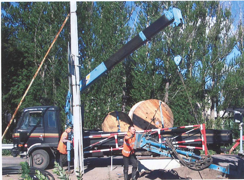
Работы по организации кабельных переходов под железнодорожными путями
