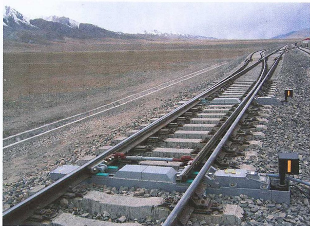
Шпальный стрелочный электропривод CTS-2
