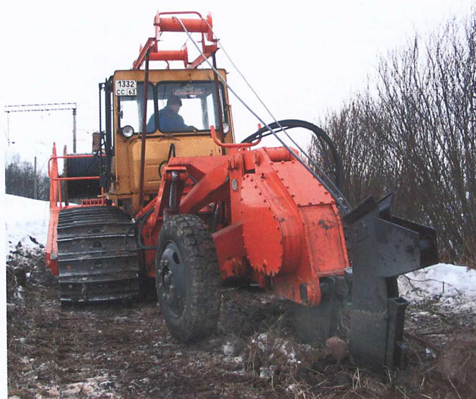
Укладка кабеля в грунт
