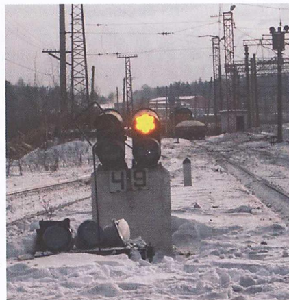
Светофор с СЖДМ на станции Шувакили Свердловской дороги
