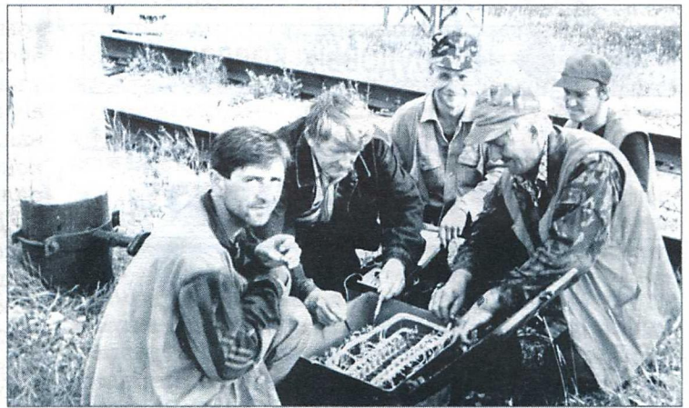
Электромеханики К.Б. Пономарев, О.В. Теньрюков, электромонтер А.Г. Гаврилов, начальник участка А.П. Башков и электромеханик И.В. Ковригин (слева направо) меняют монтажные провода в путевой коробке
