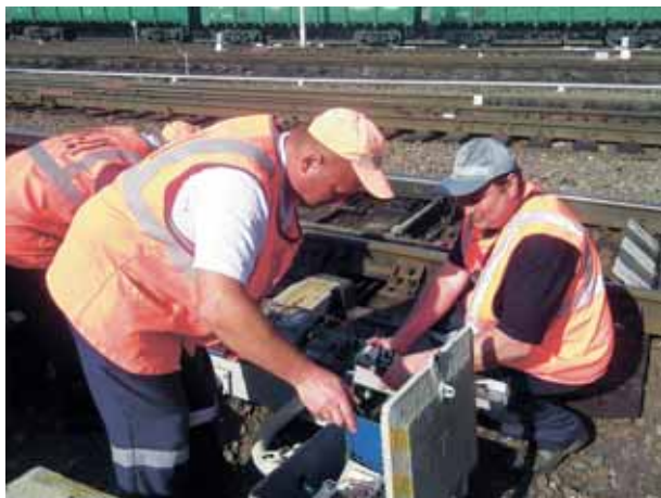
Поиск неисправности в схеме управления электроприводом во время конкурса «Лучший по профессии электро-механик СЦБ»
