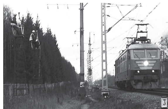
Рисунок 7 – Видеосъемка прохода токоприемников электровоза с вышек
