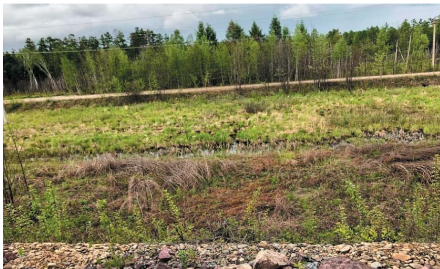
Рис. 3. Нарушение стока вод в пазухе между железной и автомобильной дорогами (298 км Адиканского обхода Буреинского водохранилища железнодорожной линии Известковая — Ургал) (фото авторов)
