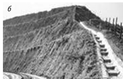
Рис. 2. Укрепление канав на железной дороге в Бразилии [8]: а — общий вид участка работ; б — выпуск нагорной канавы в виде быстрого течения
