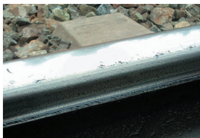
Рис. 8. Рельс после прохода грузового состава массой 22 000 т
