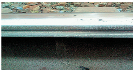
Рис. 4. Рельс после прохода рельсосмазывателя
