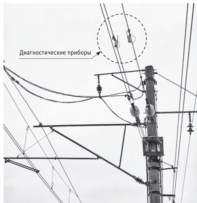
Рис. 4. Диагностические приборы на участке скоростного движения Санкт-Петербург — Москва
