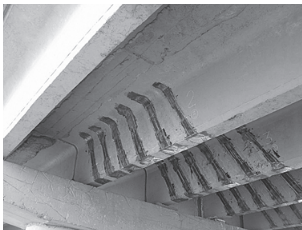
Рис. 2. Конструкция усиления железобетонного пролетного строения композиционными материалами
