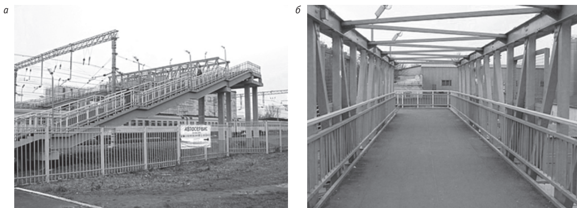
Рис. 4. Пешеходный мост с цельнокомпозитным пролетным строением: общий вид моста (а) и проходной части (б)
