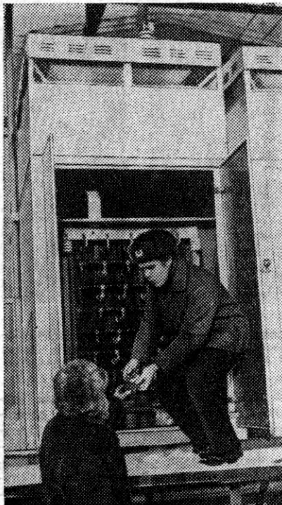
Идет наладка-ревизия кремниевого выпрямителя с естественным охлаждением
