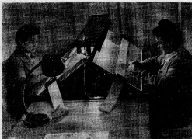
Электровозное депо Харьков-«Октябрь». Техники А. П. Сергиенко и К. М. Терешкина за расшифровкой скоростемерных лент на специальном столе.
