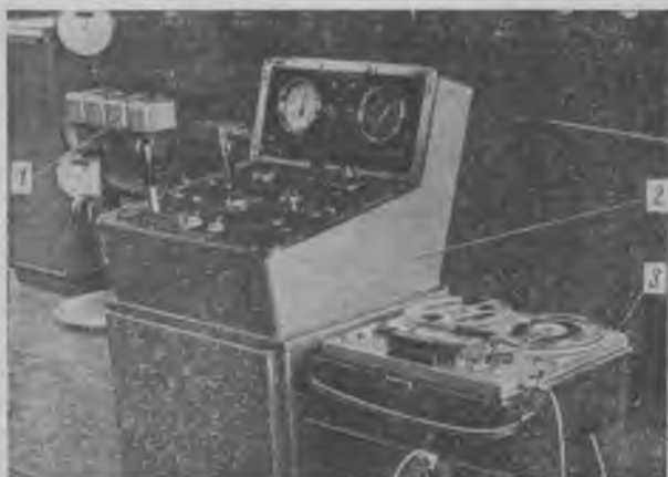
Рис. 1. Магнитограф для подачи команд программы торможения на кнопочный пульт управления краном машиниста типа PBL2: 1 — кран машиниста; 2 — кнопочный пульт управления краном машиниста; 3 — магнитограф
