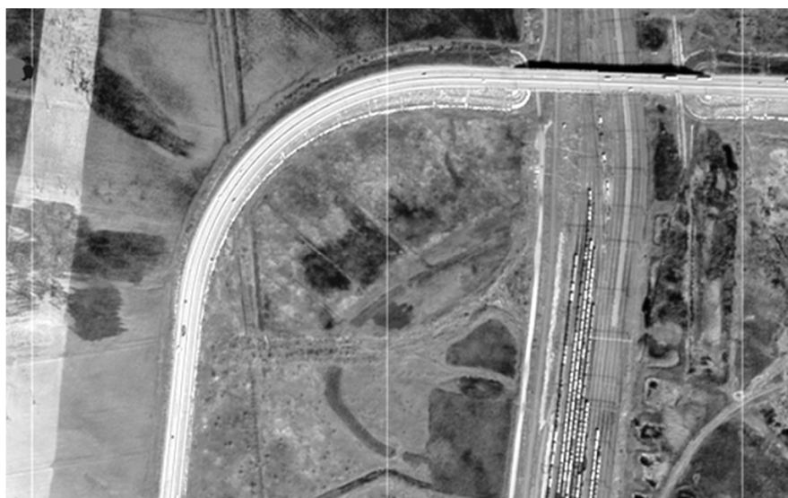
Рисунок 3 – Участок Северного обхода (вид со спутника)
