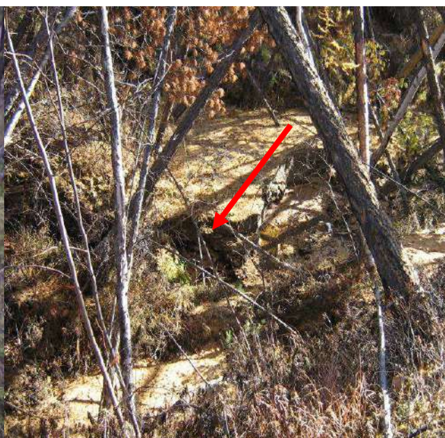
Рисунок 7 – Овраг в районе второго моста в русле ключа, в котором откладываются продукты суффозии (показано стрелкой), мощность которых достигает 1 м/год и более, сентябрь 2008 г.
