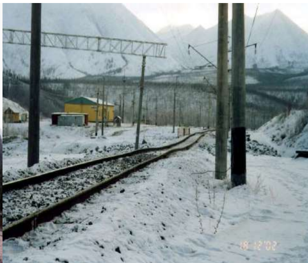
Рисунок 3 – Вид станции Казанкан после разборки путей и состояние земляного полотна, декабрь 2002 г.
