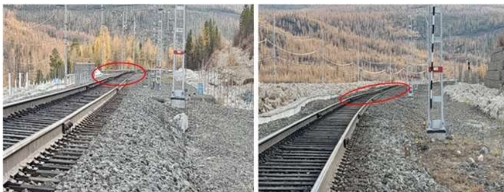
Рисунок 15 – Осадки пути на разных участках станции Казанкан (2023 г.) по данным инженерно-геологической базы ст. Северобайкальск
