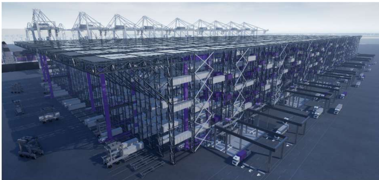
Рисунок 1 – Контейнерный терминал «BOXBAY High Bay Store»
