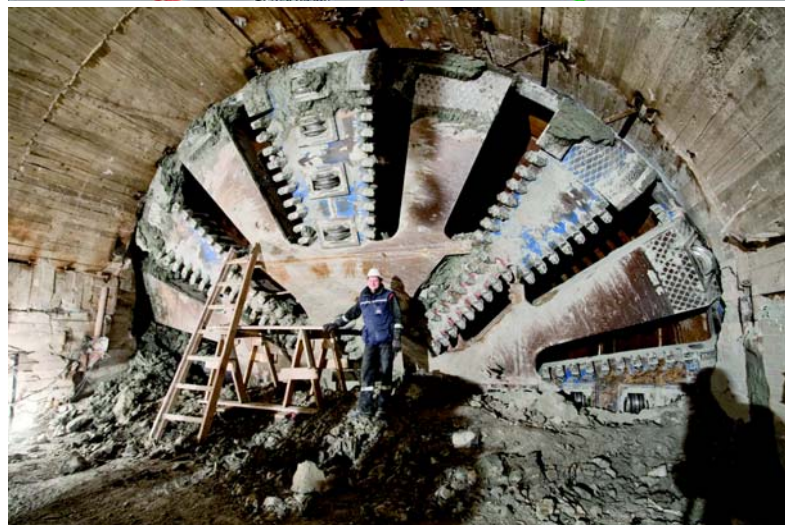
Ротор механизированного щита вышел в натяжную камеру.
