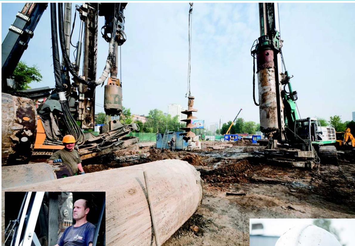
Здесь уже забурено более двухсот свай.
