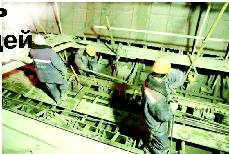
Готовится очередная заходка под укладку путевого бетона.
