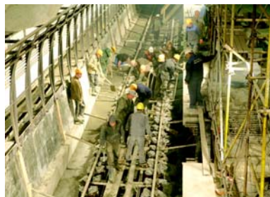
Укладка путевого бетона.
