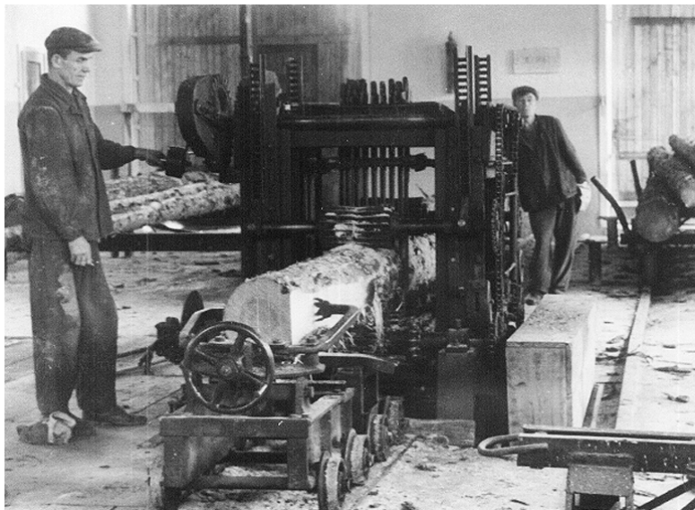
Новый цех распиловки пиломате- риалов. Слева — пилорамищик М. Чесноков.
