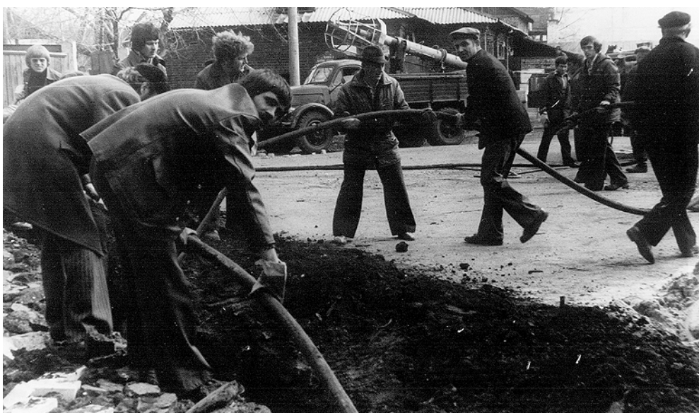
Работники Пензенского энергоучастка на укладке высоковольтного кабеля в день Всесоюзного субботника 12 апреля 1978 года.
