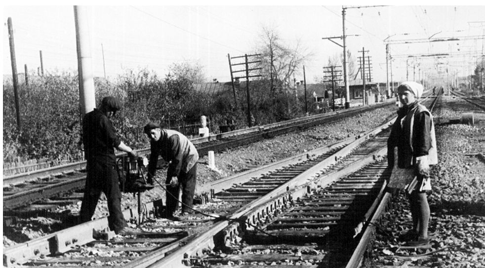
Зашурупование стрелочного перевода шуруповертом ШПМ-2: монтеры пути К.Х. Шабакеев и И.И. Маслихин, сигналист В.И. Мартынова. 7-й околоток пути, ст. Кузнецк.
