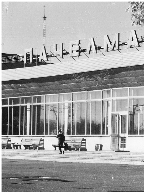
Вокзал станции Пачелма.
