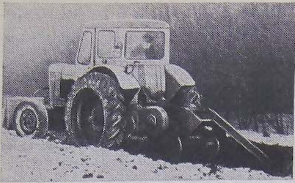
Траншею для сигнального кабеля роет траншеекопатель ЭТЦ-161
