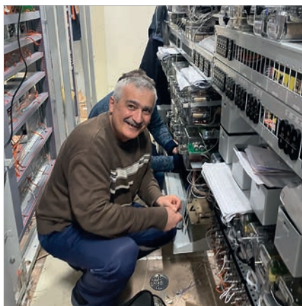
Старший электромеханик С.А. Кочарян в процессе пусконаладочных работ на путевом посту Ольшанка
