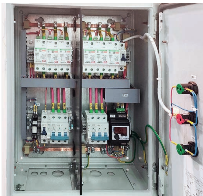
Выставочный вариант нового ЩЗИП.ЖАТ-ЩВПУ-IP30-УХЛ4
