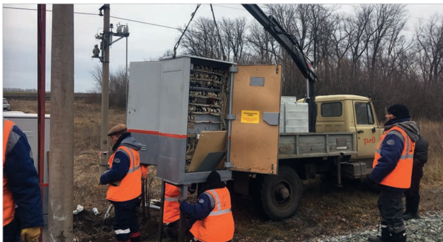
Во время технических мероприятий на станции Андреевка
