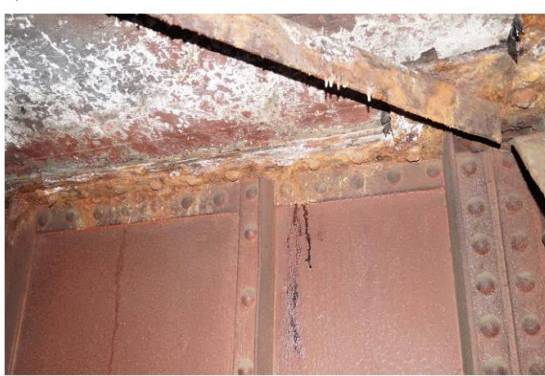
Рис. 9. Повреждения пролетного строения: а – выщелачивание цементного камня на нижней поверхности плиты путепровода; б – коррозия верхних поясных уголков путепровода
