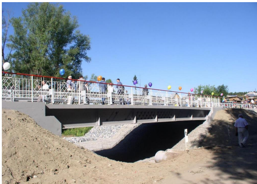
Рис. 4. Автомобильный мост через р. Пашенку в Новосибирской области
