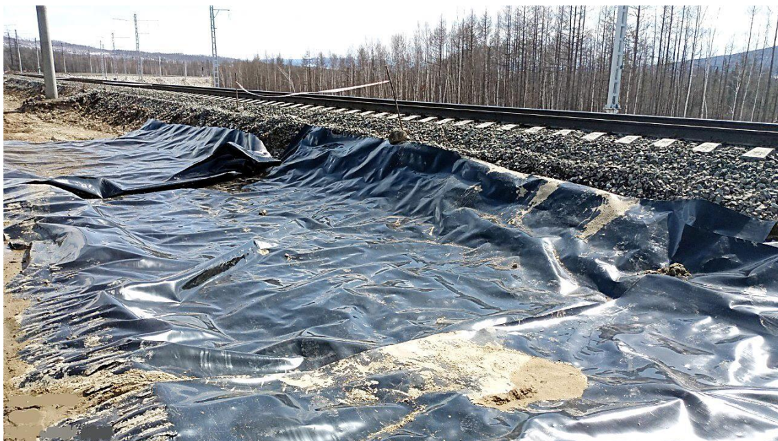
Рис. 12. Геомембрана с двусторонним термоскрепленным геотекстилем на БАМе
