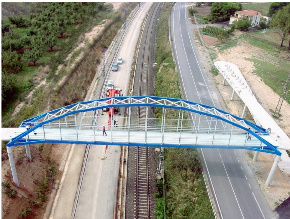
Рис. 2. Пешеходный мост из стеклопластика в г. Ллейда [3]
