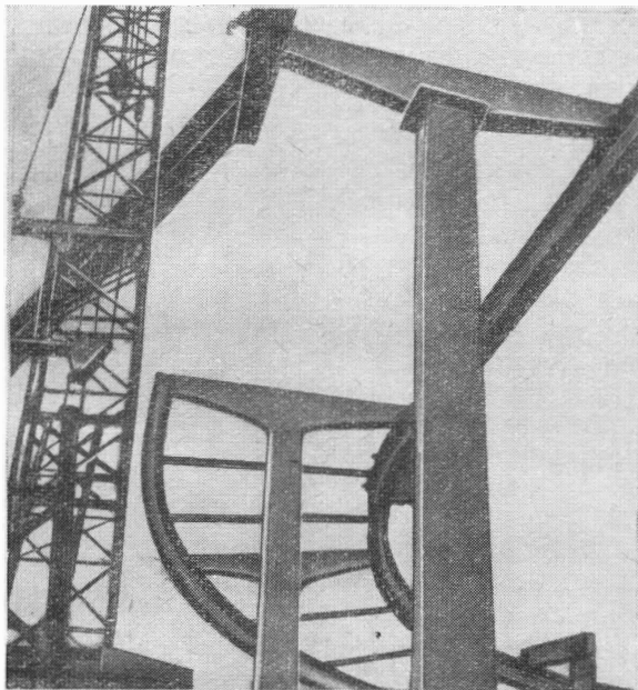
Рис. 94. Монтаж с помощью кранов эстакады монорельсовой дороги в Нью-Йорке
