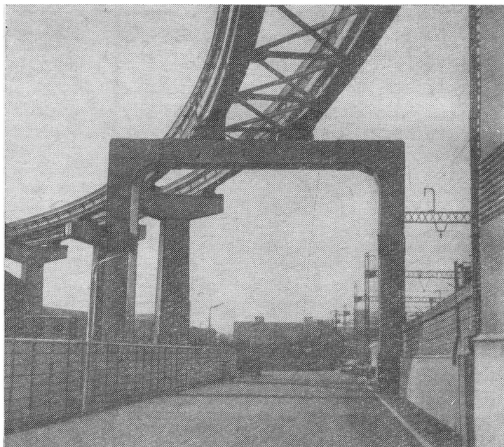
Рис. 74. Устройство эстакады в Токио, проходящей над улицей
