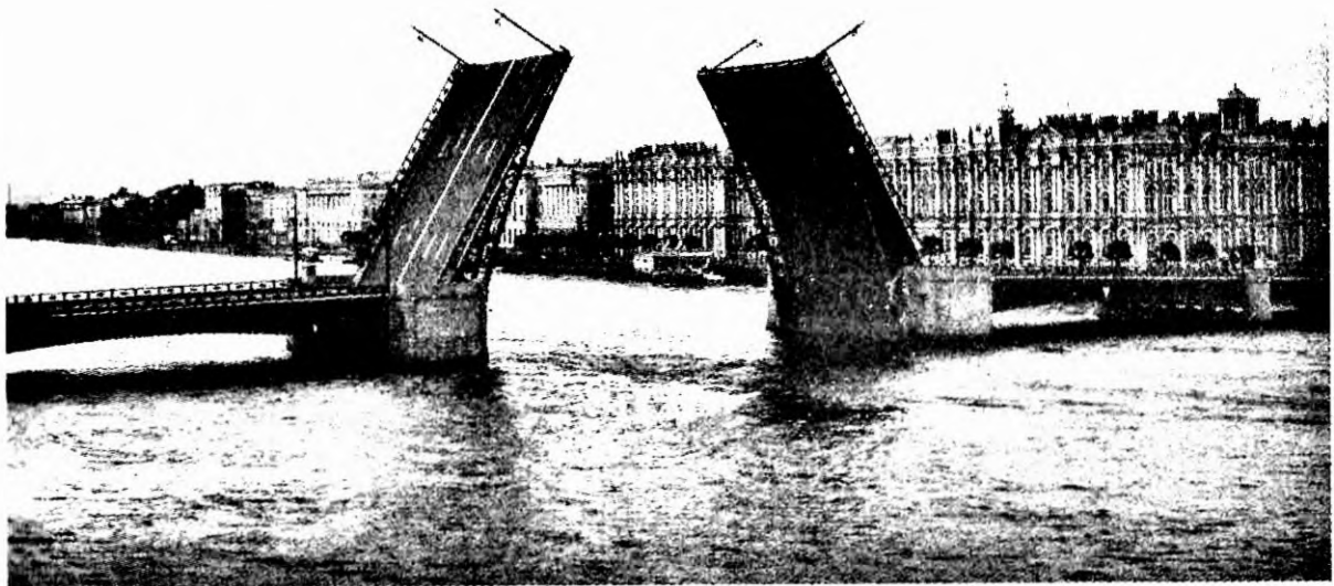
Дворцовый мост. 1912—1916. Инженер А.П. Пшеницкий, архитектор Р.Ф. Мельцер
