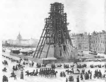
Подъем Александровской колонны на Дворцовой площади в Санкт-Петербурге в 1834 г. с помощью механизма и технологии, разработанных А. Бетанкуром
