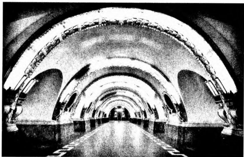
Подземный зал станции «Площадь восстания». 1955
