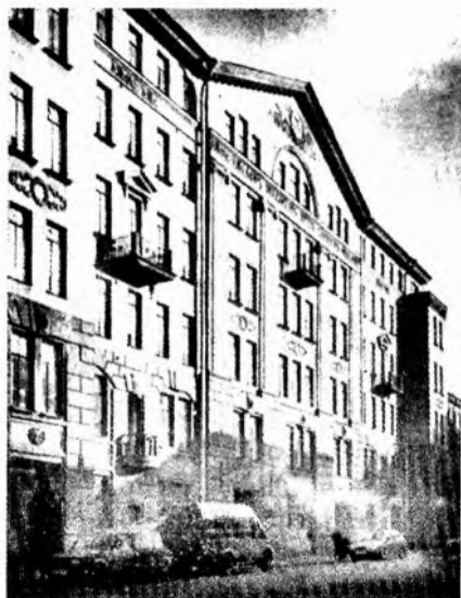
Здание Общества инженеров путей сообщения. Автор А.А. Барышников. 1912—1913. Бородинская ул., 6. Ныне Железнодорожный техникум
