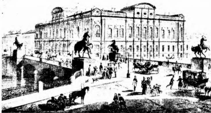
Аничков мост — перестроен в 1841 г. из деревянного в железе и камне под руководством инженеров А.Д. Готмана и И.Ф. Буттаца
