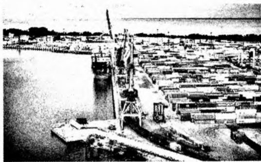
Терминал контейнеров в Петербургском порту
