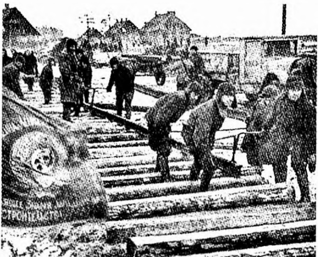
На строительстве железнодорожной ветки Войбокало—Ладога. 1 марта 1942 г.
