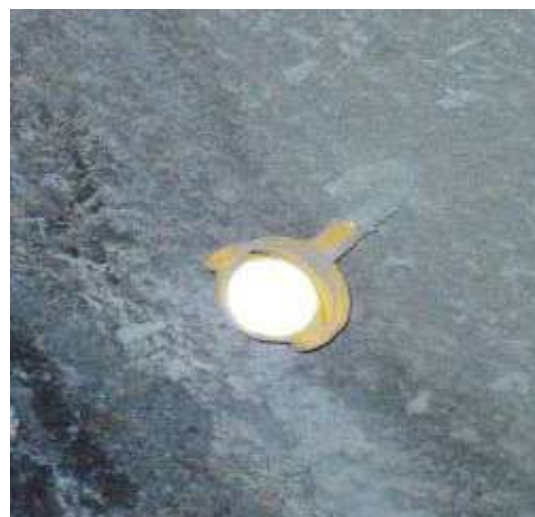
Рис. 2. Геодезическая марка, закрепленная в набрызг-бетоне
