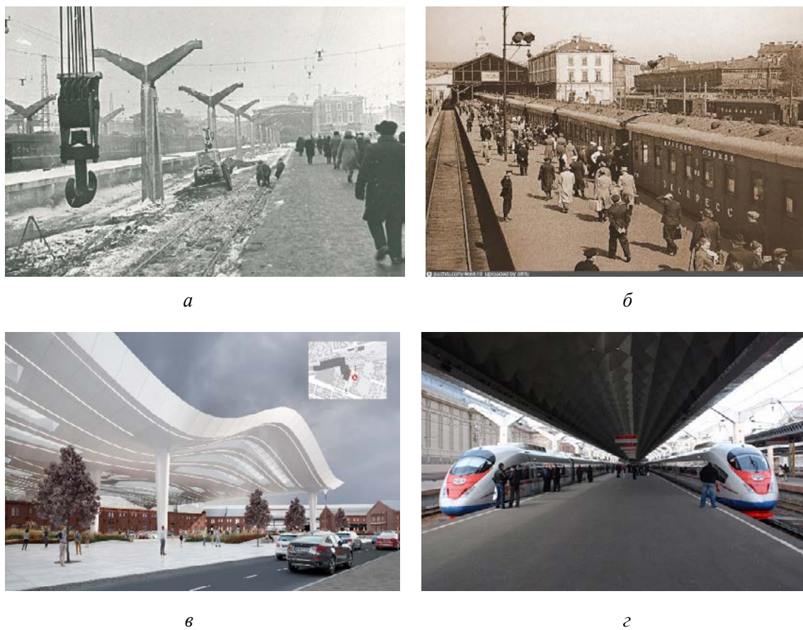
Рис. 3. Фотографии решений на вокзальном комплексе Московского вокзала: а — 1948 г., прибытие поезда «Красная стрела» на Московский вокзал. Навес отсутствует; б — 1977–1978 гг., реконструкция пассажирских платформ и сооружение металлических фронтонов и навесов над перронами; в — платформа Московский вокзал в текущее время; г — проектное решение прилегающей территории Московского вокзала при строительстве высокоскоростной железнодорожной магистрали «Москва — Санкт-Петербург»
