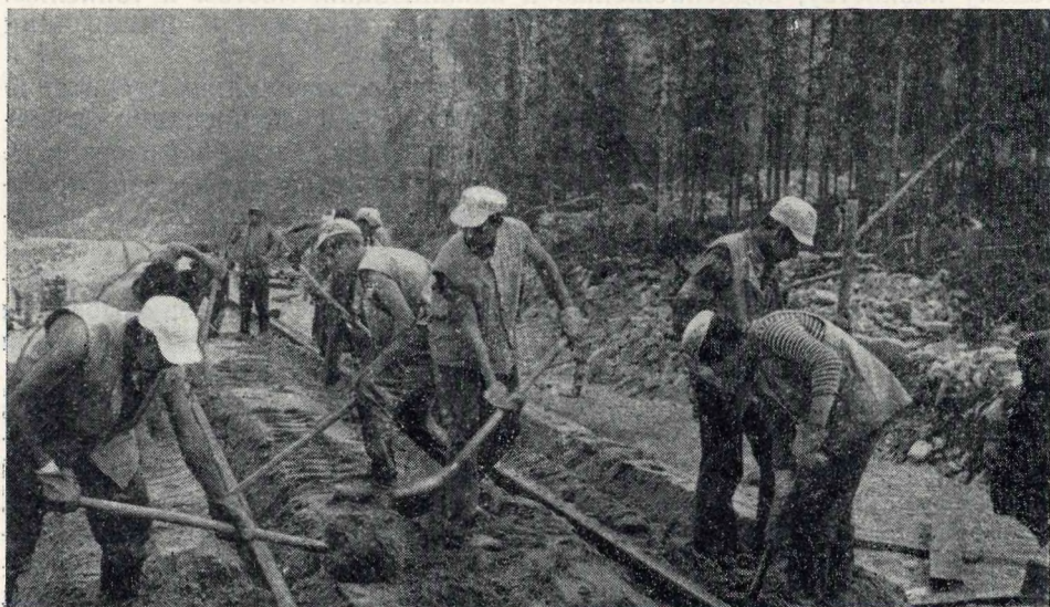
Студенческий строительный отряд укладывает путь на БАМе
